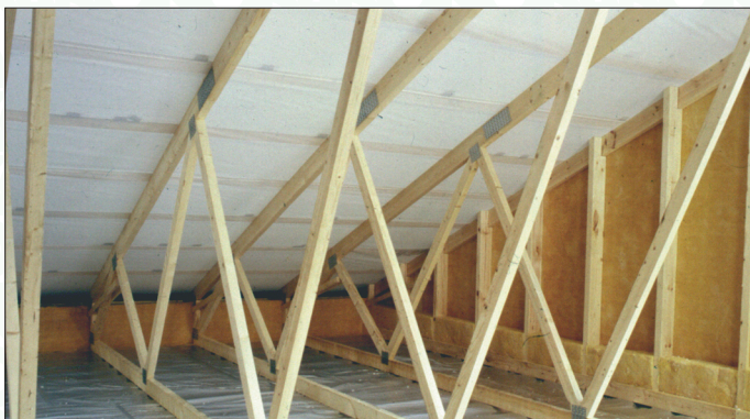
Pööningule aluskatte alumisele pinnale pääseb niiskus välis- ja siseõhust. Kui välistemperatuur tõuseb kiiresti, kondenseerub osa niiskusest aluskatte aluspinnale. Rankka aluskate suudab kogu selle niiskuse endasse imeda.
